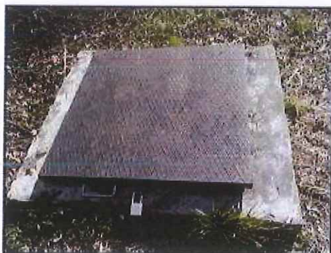
Figure 6. Vue de l'extérieur du captage
